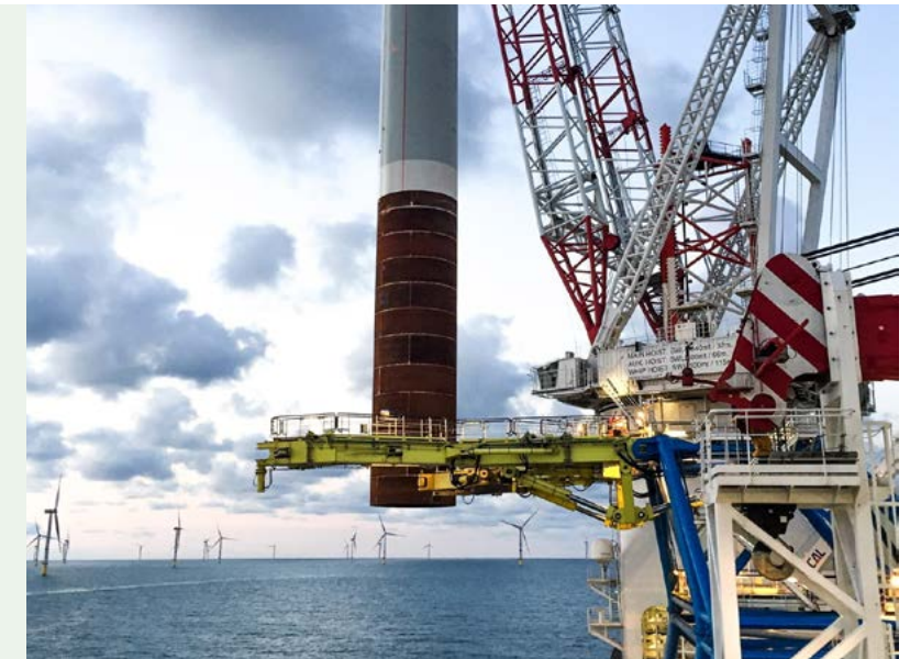
Parc éolien Deutsche Bucht de Northland Power (en construction)
